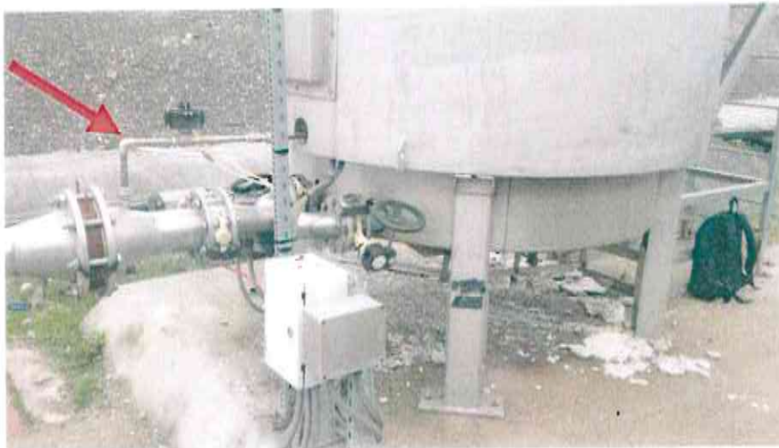
Figura 3 Altra vista del gruppo controllo di adduzione biogas.
