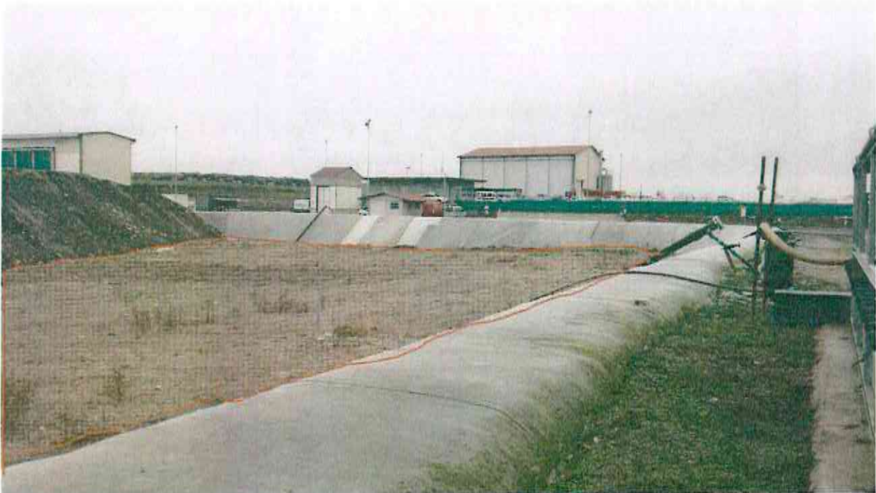
Figura 13 Vista dell'angolo nord ovest della vasca lotto 3. Si notino le tubazioni di prelievo del biogas dal fondo discarica. La retinatura racchiusa nella linea rossa, indica la zona interessata dalla copertura provvisoria che interessa il lotto 3, al di sotto della quale i rifiuti risultano già stati stoccati da tempo, senza aver realizzato alcuna rete di captazione orizzontale del biogas.
